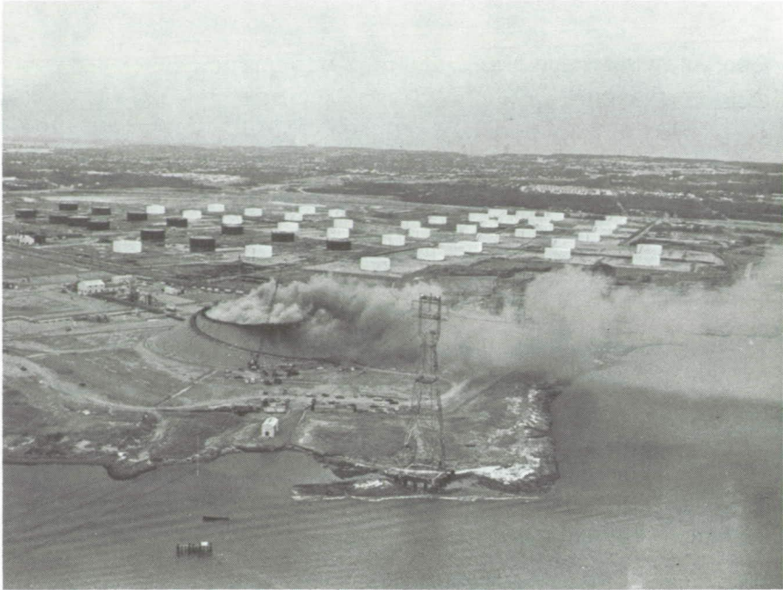
Figure VII-1. - LNG storage tank fire.
